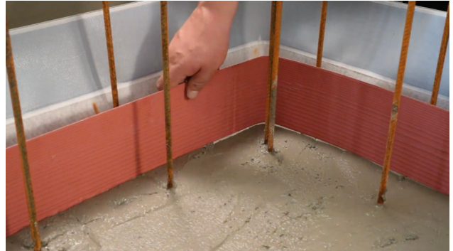
Platzieren, Einbindtiefe 30 mm
