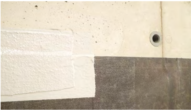
Abschlüsse bei Bitumenabdichtung
