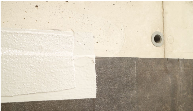
Abschlüsse bei Bitumenabdichtung
